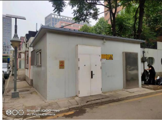
医疗垃圾暂存间
