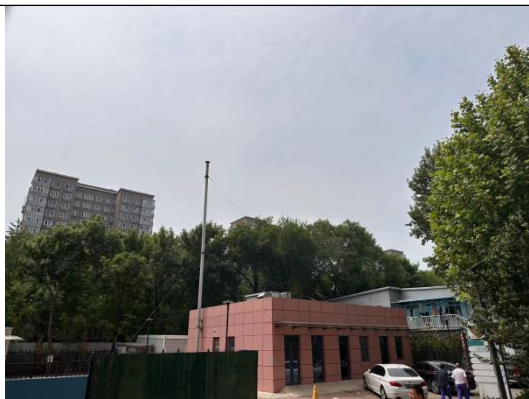
本项目改扩建污水站及排气筒
