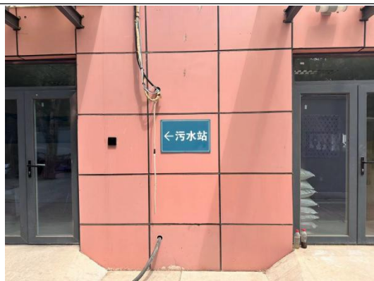
本项目改扩建污水站
