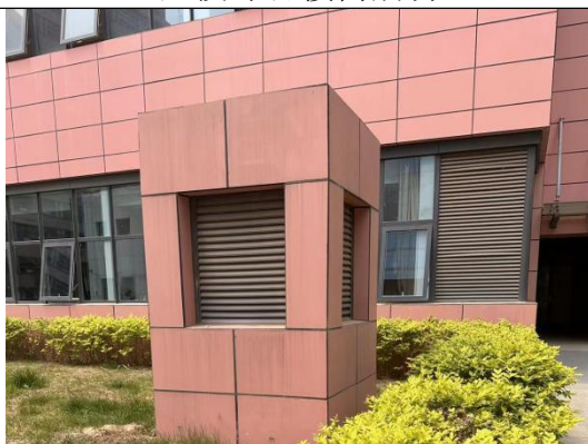
地下车库排放口
