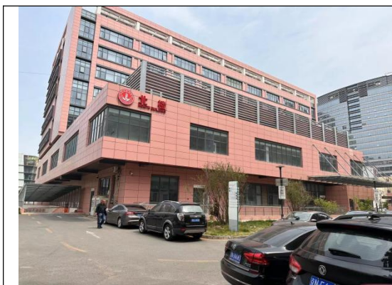
本项目医技综合楼
